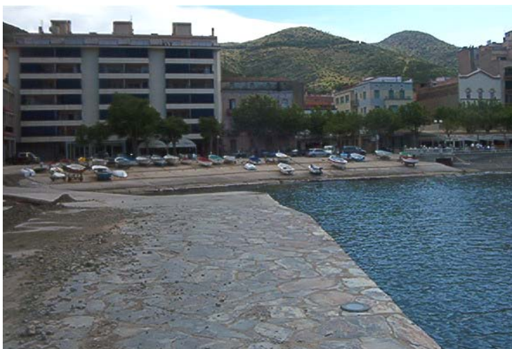
Fotografia 8. S'observa la rampa d'avarada abans de la recuperació de la platja
