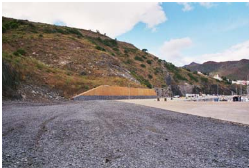
Vista del mur i del talús.
